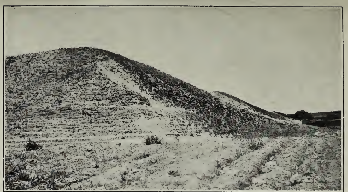
MUR NORD : Vue extérieure prise de l'angle N.-E.
